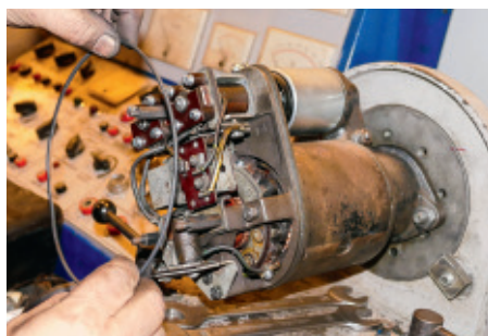
Für Wind und Wetter: Den O-Ring vergessen viele Bastler am Ende der Arbeit. Eindringendes Wasser zerstört dann ganz schnell die Relais
