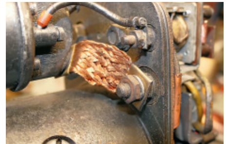
Leistungsträger: Nun wird das hoch belastete Stromband gegen ein Neuteil getauscht. Das überträgt die hohen Ströme problemlos
